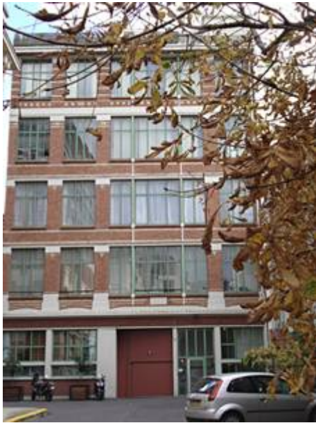
Perpendiculaire au centre de l'EPS Maison-Blanche, l'immeuble en fond de cour. (septembre 2010)
